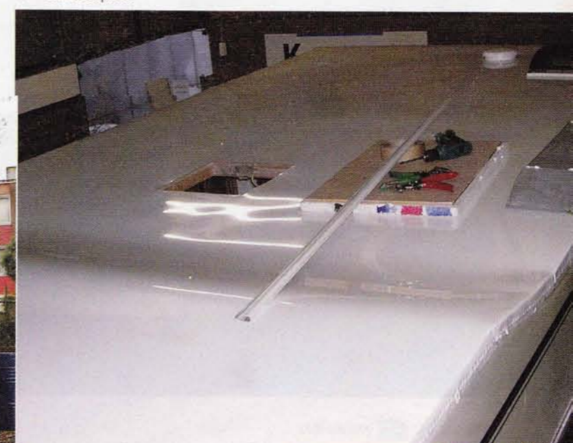
De nieuwe dakplaat.
